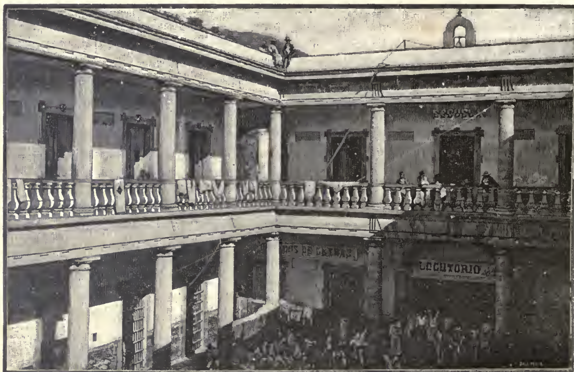
Interior de la Alhóndiga de Granaditas (Estado actual)
