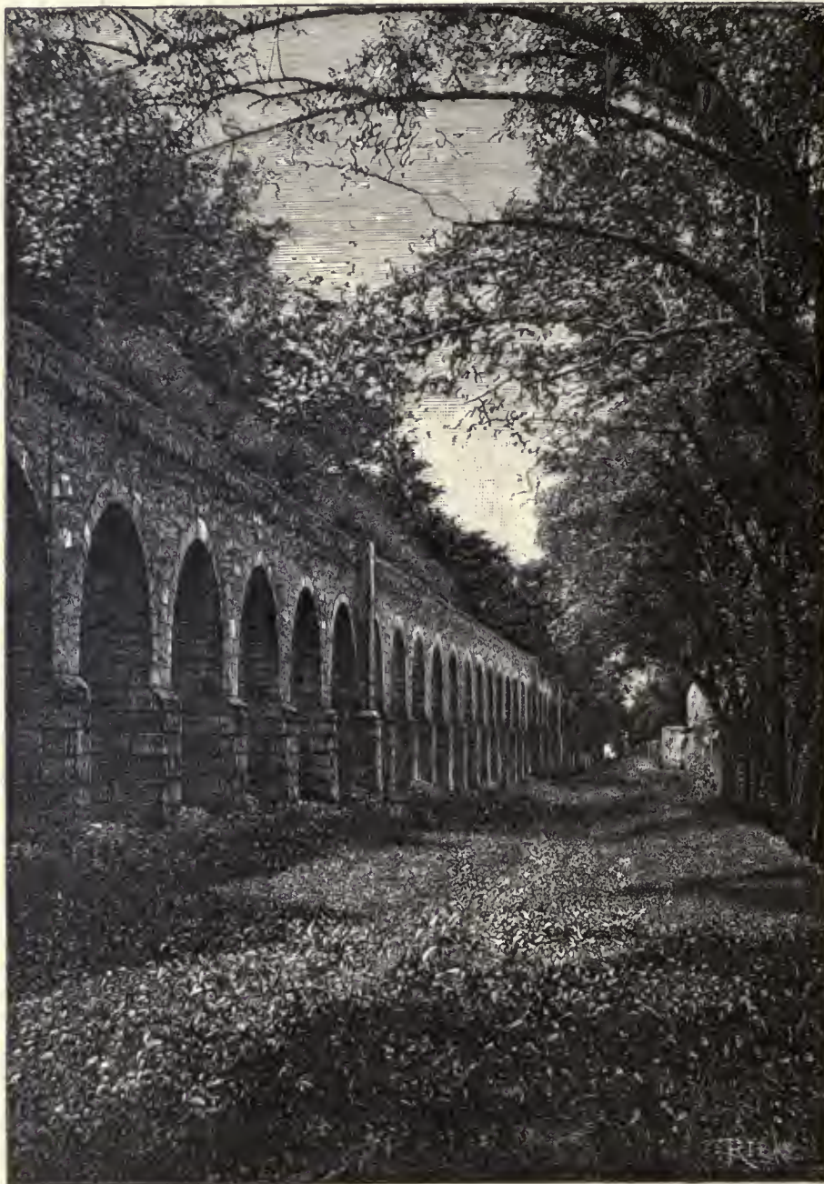
Acueducto de Valladolid (hoy Morelia)
