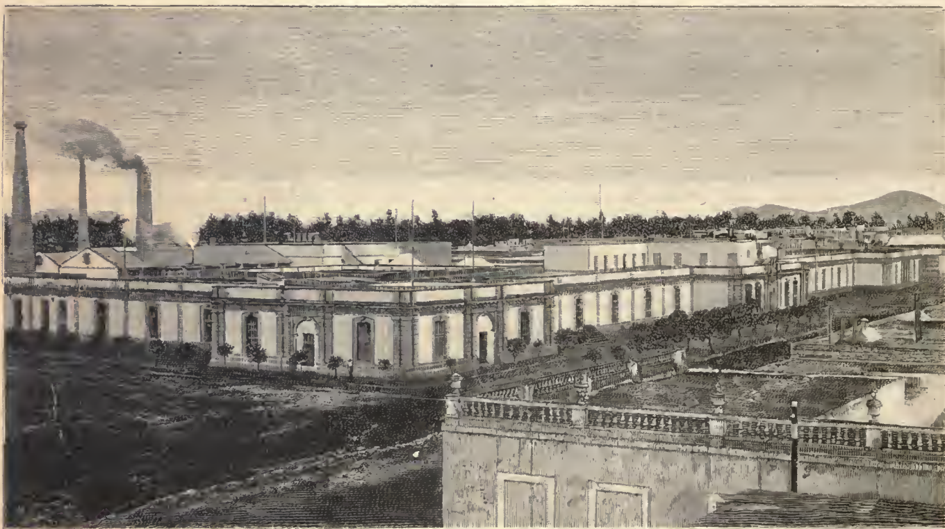
Vista de la Ciudadela de México (Estado actual)
