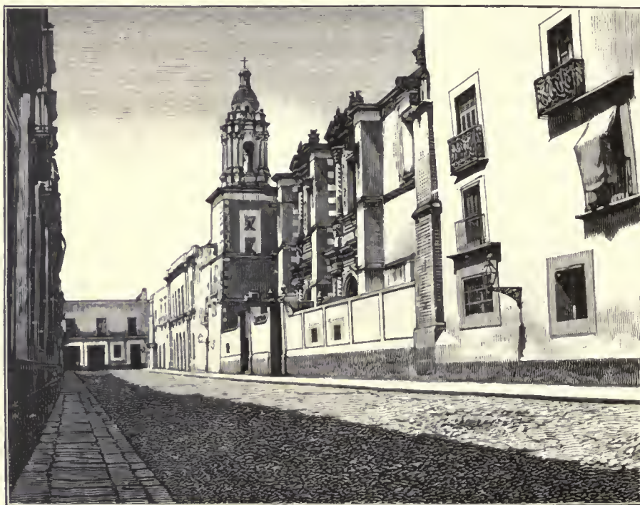
México. — Vista del convento de Santa Teresa (Estado actual)
